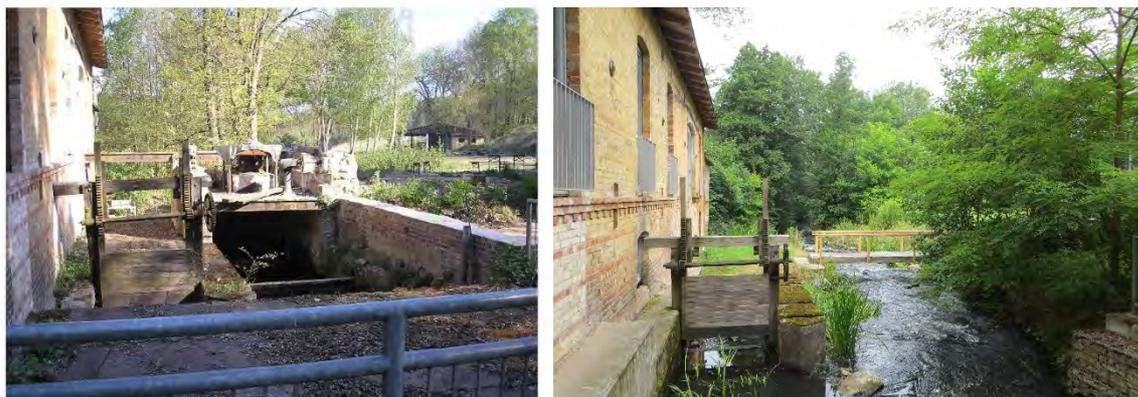
Abbildung 5: am ursprünglichen Ort belassene Wehrtafel (linkes Foto: Zustand des Wehrs vor Umbau, WBV Finowfließ 2012, rechtes Foto: Zustand 2018, links im Bild die vor Ort belassene Wehrtafel, W.O.W.)
